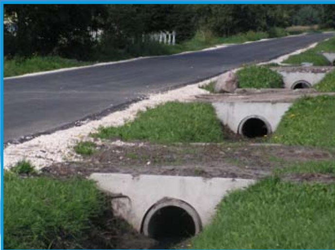
Przebudowa odcinka drogi w Kępiu w ramach usuwania skutków powodzi
