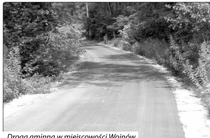
Droga gminna w miejscowości Wojnów
