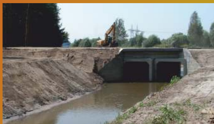
Nowy most na Strudze Oleśnickiej
