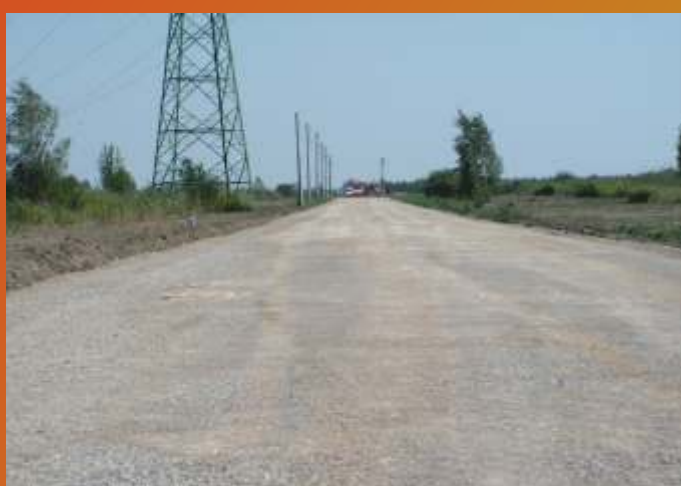
... brakuje tylko nawierzchni asfaltowej...
