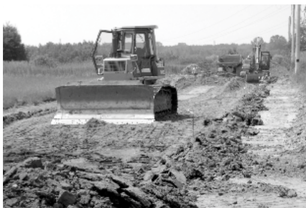
Początek robót na odcinku Stopnicka-Pacanowska
