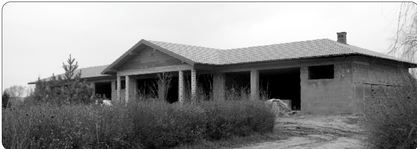
Przedszkole w budowie
